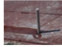
14. Particolari del collegamento del cordolo alla muratura sottostante.
